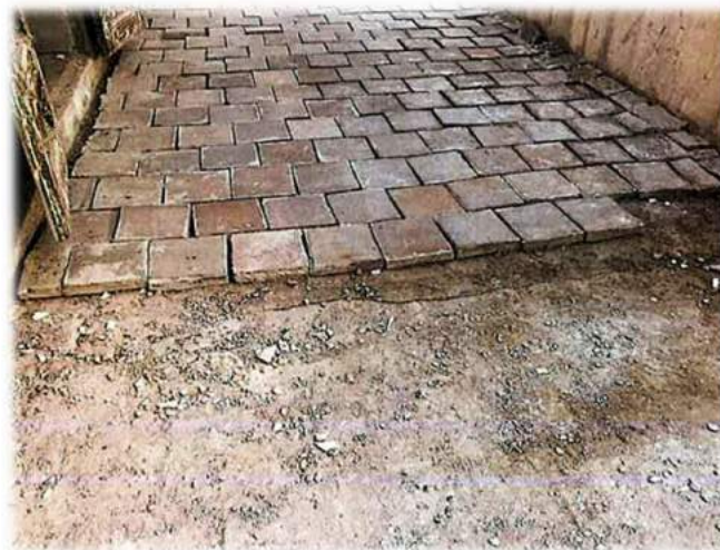
07 工程人員小心翼翼地將百年校舍二樓平台的老地磚移除(地磚將會被重用)。
